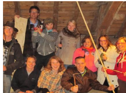
8 jongeren renoveren de vloer van de activiteitenruimte
